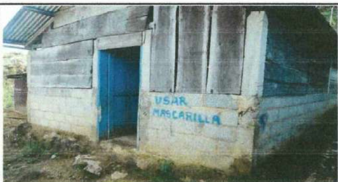
Foto 3: Sustrucion de puertas de Madera a Metal
