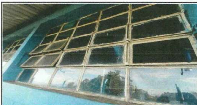
Foto 4: Mantenimiento de Ventanas Y Colocacion de Vidrios
