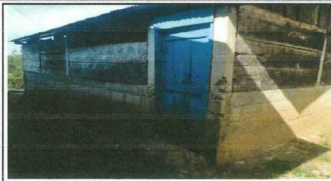
Foto 2: Rehabilitacion de Paredes
