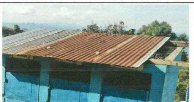
Foto 5: Sustrucion de Estructura de Techo
