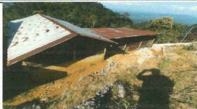
Foto 1: Sustrucion de cubierta de lamina
